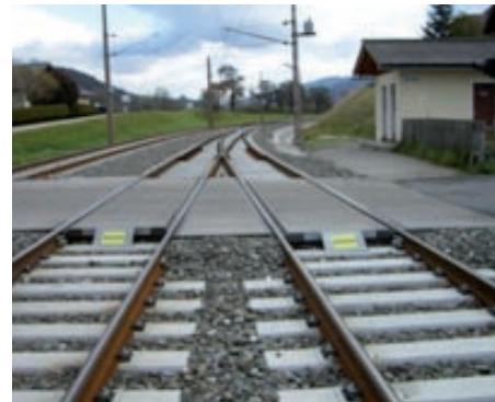
Vorteil des BODAN-Gleiseindeckungssystems: Die Elastizität des Gleises bleibt auch im Bahnübergangsbereich gewährleistet.
